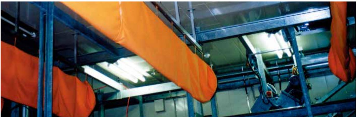
Photo19 (丸型AIR-SOXでのファン停止状態時)
